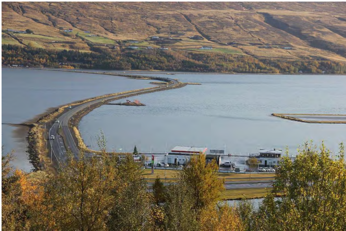
Mynd 3.1 Framkvæmdasvæði við norðurenda flugbrautar. Landfylling undir aðflugsljósin mun tengja flugbrautina við Leiruveg.
